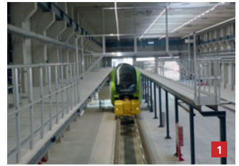
1. Festinstallierte Dacharbeitsbühne mit einer Gesamtlänge von 115 m, komplette Einhausung des Zugdaches für sicheres Arbeiten ohne Absturzrisiko
