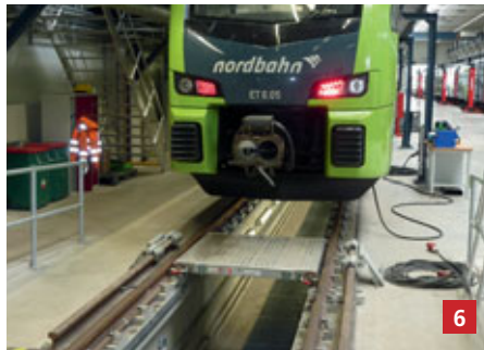
6. Gleisplatten, 2 Stück zum sicheren Überqueren der Gleisruten
