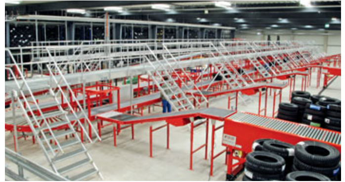
Benutzerfreundliche Laufsteganlagen erhöhen den Komfort in Ihrem Logistiklager
