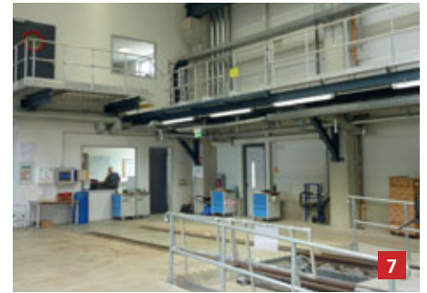
7. Anbindung an das Verwaltungsgebäude
