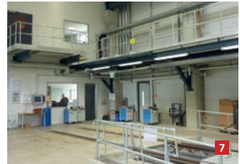
7. Anbindung an das Verwaltungsgebäude
